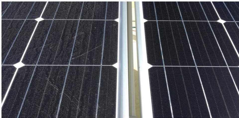
Figura 94: Fotografía 19° Medición - Panel FV Sucio (izq) y Limpio (der)
